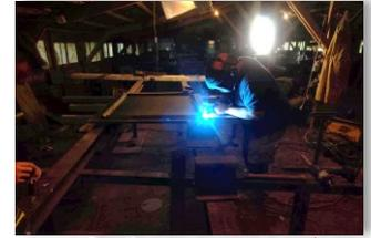
Figure 12 soudure des supports de pompe à chaleur
